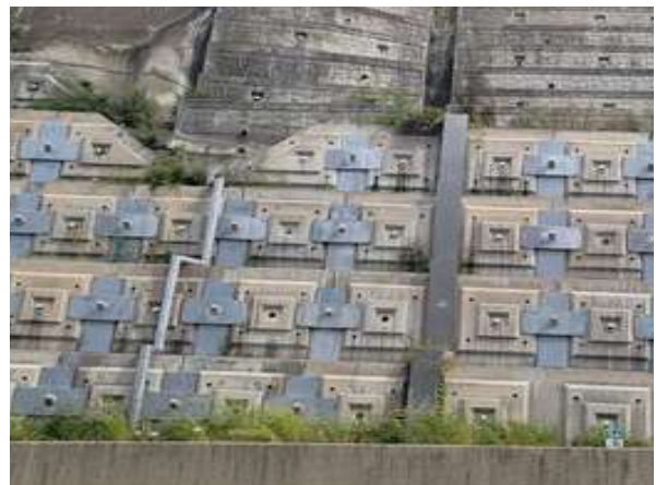
주변영향인자(절토사면부, 배수시설) 상태현황
