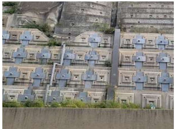
배수관, 배수로 전경
