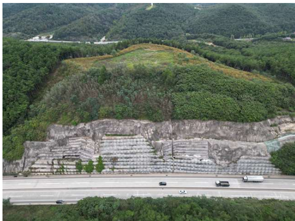
주변영향인자(절토사면부, 배수시설) 상태현황
